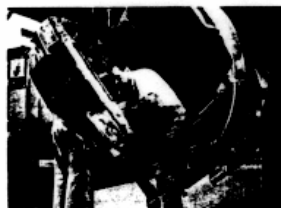
Erste Qualität in der Unterbodenmontage: ergonomisch günstige Fertigung mittels Schwenkgehänge.
